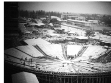
ภาพการก่อสร้าง ตึกกลม (มอบให้โดย อาจารย์อมร ศรีวงศ์ สถาปนิกผู้ออกแบบ)
