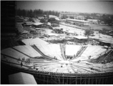
ภาพการก่อสร้าง ตึกกลม (มอบให้โดย อาจารย์อมร ศรีวงศ์ สถาปนิกผู้ออกแบบ)
