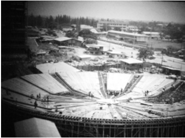
ภาพการก่อสร้าง ตึกกลม
